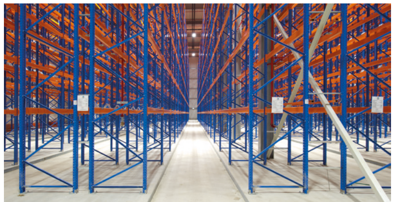
Ein Foto, das man nur einmal erstellen kann, nämlich kurz vor Inbetriebnahme des neuen Hochregallagers von Med-X-Press (Höhe: 16 Meter). Es bietet Platz für mehr als 10.000 neue temperaturgeführte Palettenstellplätze.
