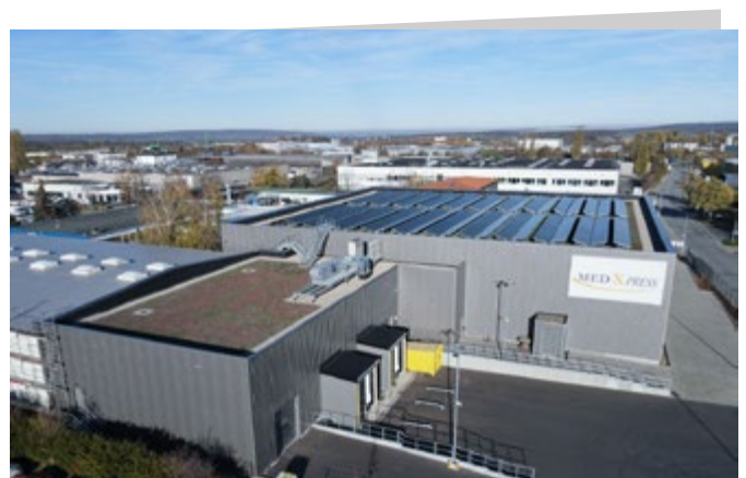
Nachhaltiges Bauen: Das neue Betäubungsmittel-Lager
