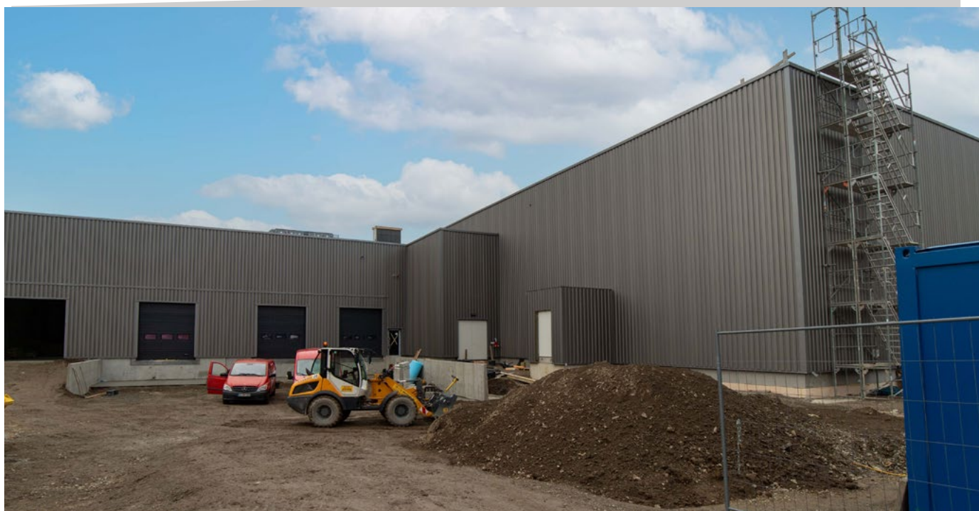
BtM-Lager kurz vor der Fertigstellung: Beim Bau wurde der Nachhaltigkeitsgedanke in besonderem Maße berücksichtigt
