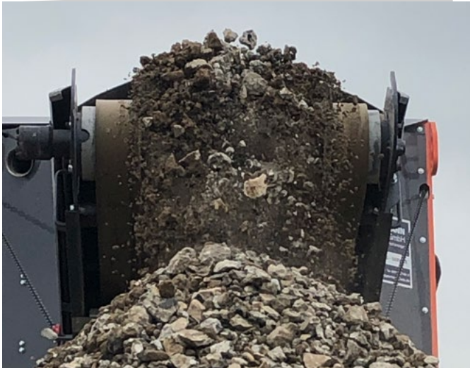
Steinbrecher zur Aufarbeitung von Abfällen direkt auf der Baustelle
