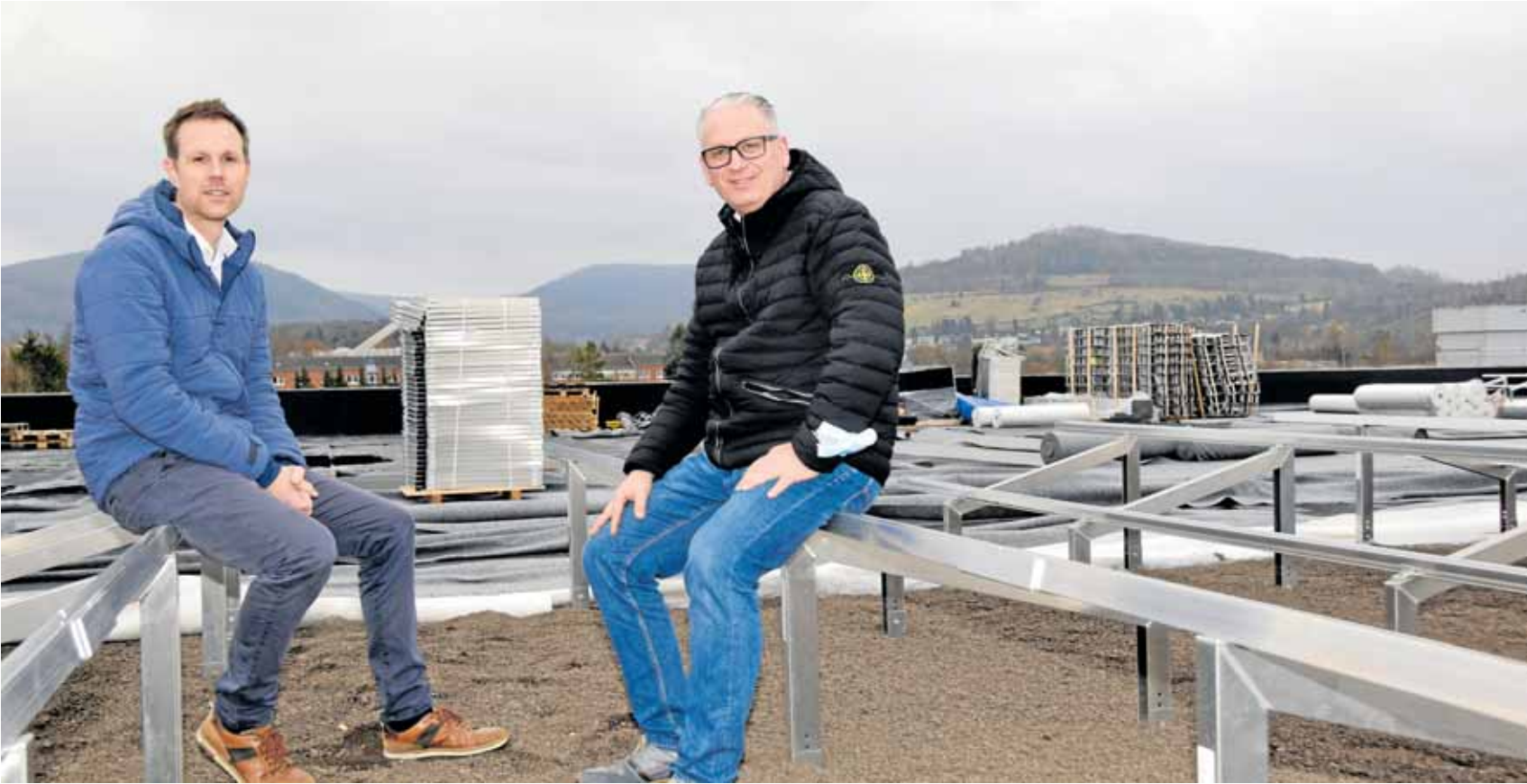
Gute Aussichten: Die Med-X-Press-Geschäftsführer Christian Frede und Lars Dörhage (re.) auf dem Dach des neuen BTM-Lagers in der Baßgeige. Mit Dachbegrünung und Photovoltaikanlage will der Pharmadienstleister auch einen nachhaltigen ökologischen Fußabdruck setzen. Fotos: Kleine
